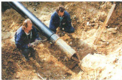
Relling – zaťahovanie plastového potrubia do poškodeného potrubia
